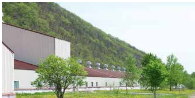
Рисунок 1. Общий вид основного здания «Рязановского ЭПРЗ» Приморского края
